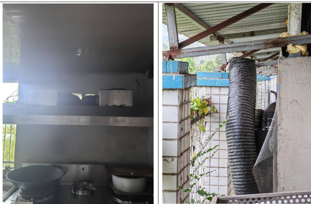
图 3-3 食堂油烟净化器及排气筒
